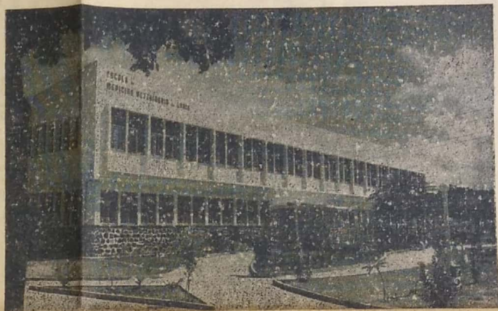
Vista panorâmica do edifício da E. M. V. B.
