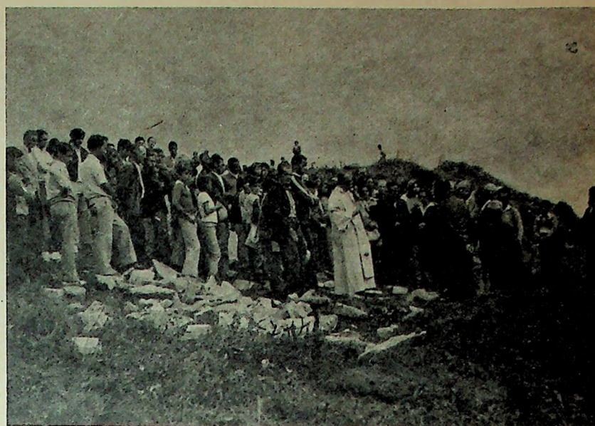
Bênção do terreno onde será construído o miniposto de saúde que atenderá o Bairro dos Funcionários e Vila Nova.
