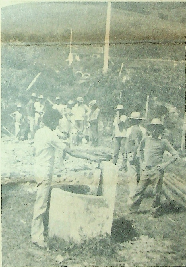
Local onde será construído o miniposto (depois da demolição da casa)
