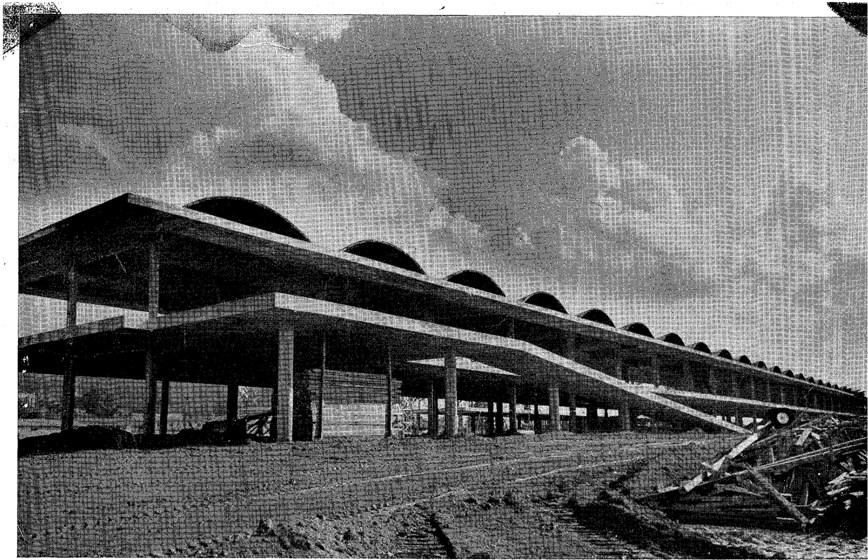
Estrutura em 21 de Setembro de 1953
