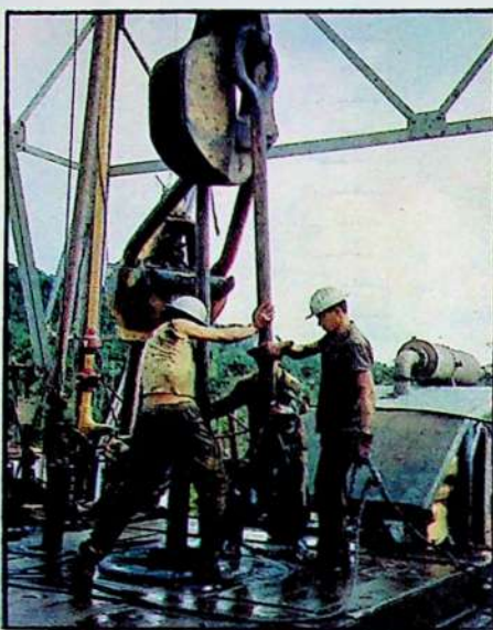
Perfura os poços em terra.
