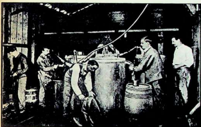
Os balões eram inflados com hidrogênio. O próprio Santos Dumont fabricava este gás.
