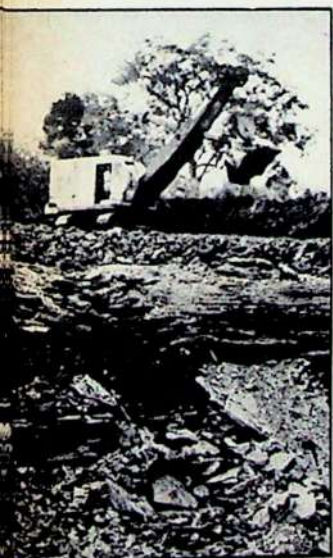
Escavadeiras retiram o minério das minas.
