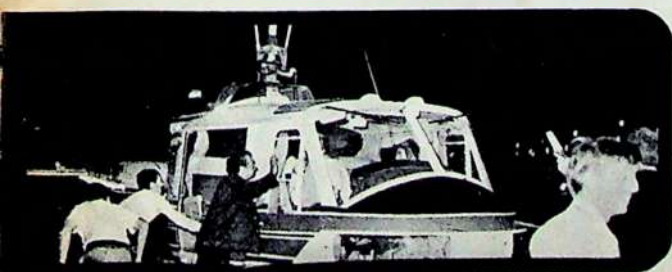
Os helicópteros salvaram mais de 400 pessoas no incêndio do edifício Andraus, em São Paulo.
