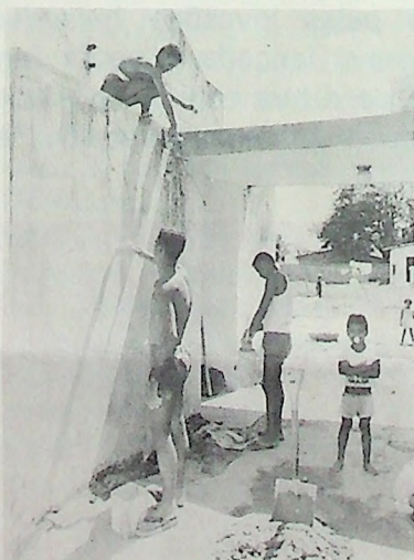
Reforma da creche.
