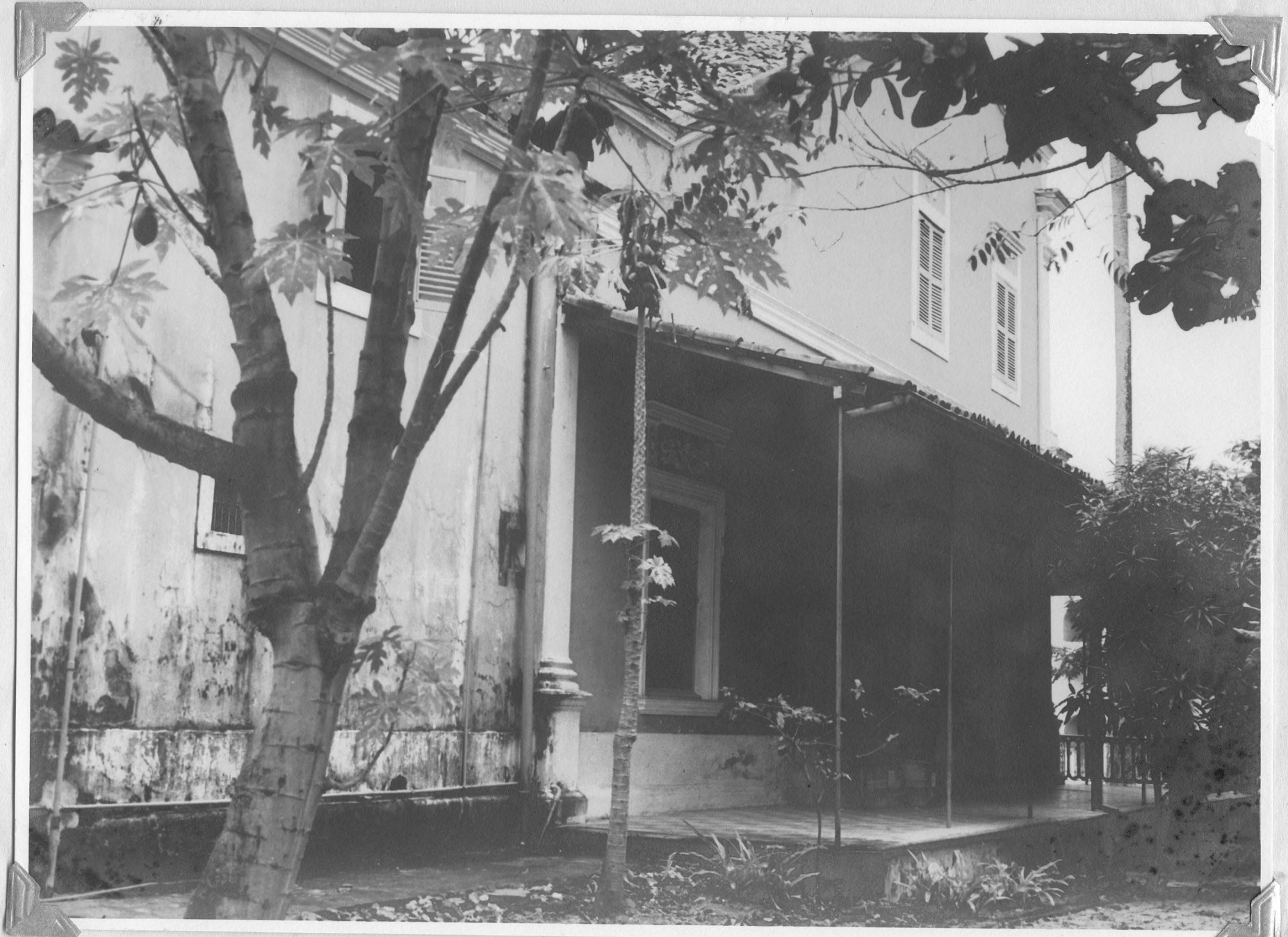
fachada lateral esquerda
