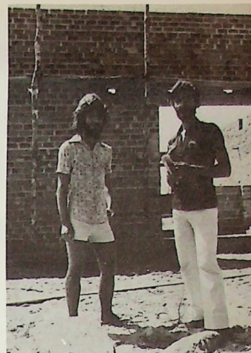
O Centro Comunitário com suas paredes já levantadas é o resultado do esforço dos moradores de Santa Cruz Cabralia.
